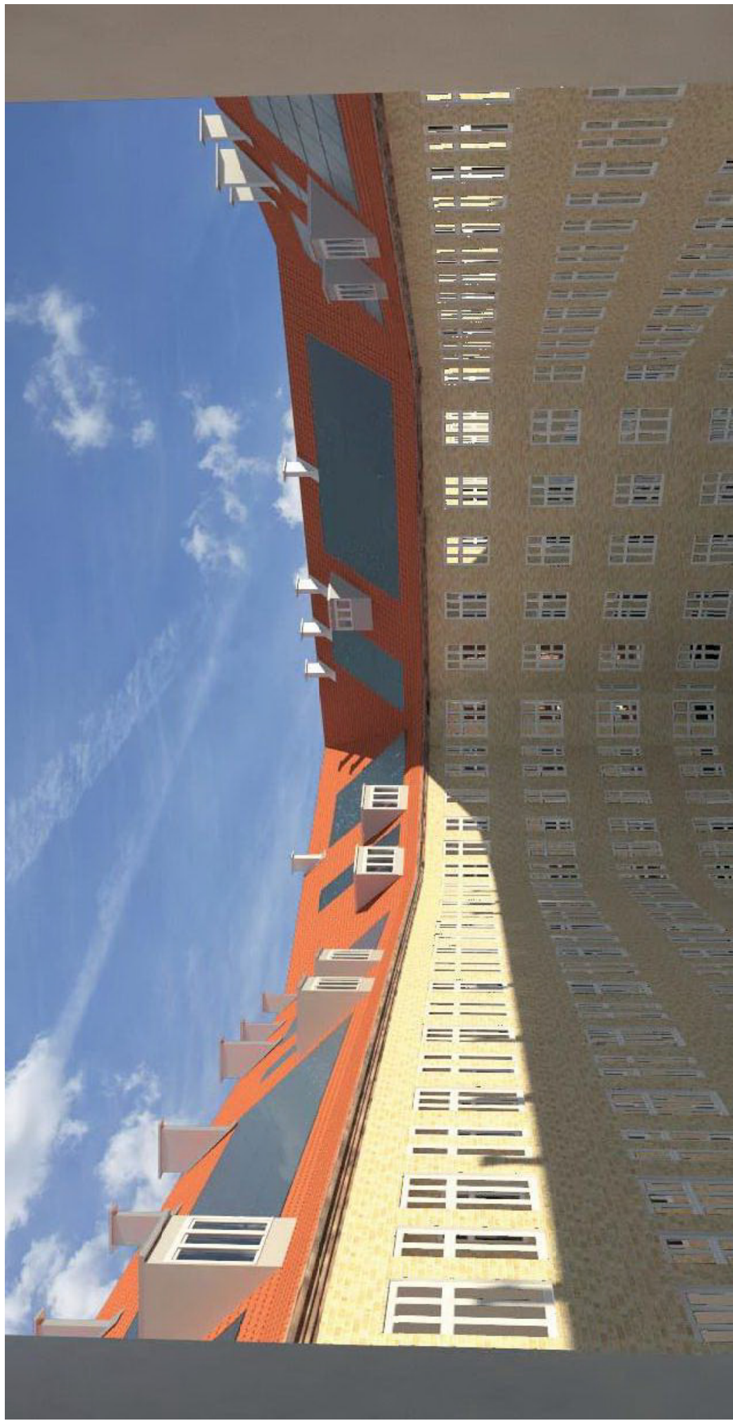
Udsigt fra vestvendt 4. sals lejlighed til solceller på gårdside: Anbefalet løsning - solceller integreret i tag, skjulte monteringsbeslag
